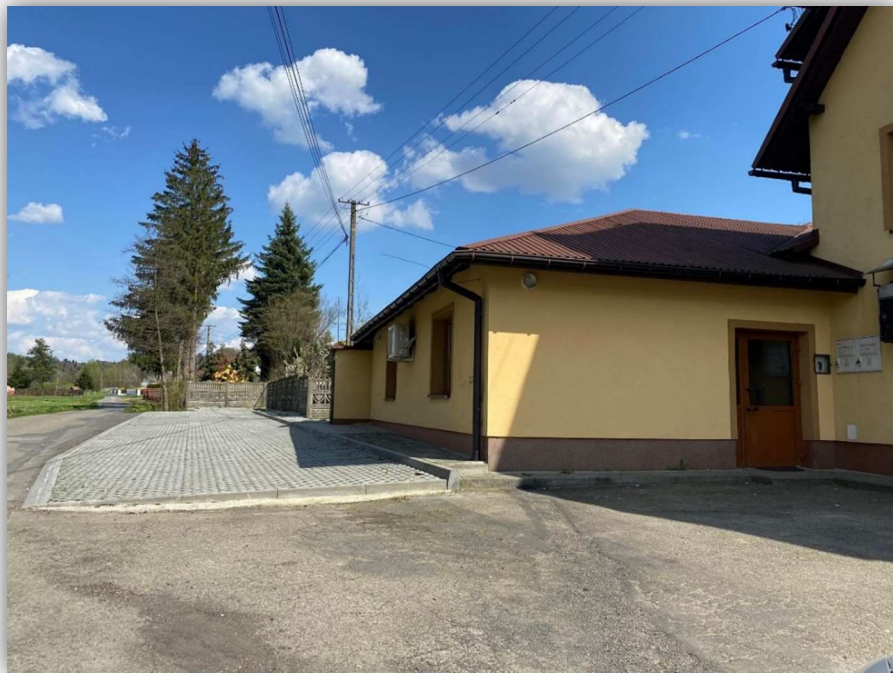
Utwardzenie terenu płytami ażurowymi na działce Domu Ludowego w Bączalce
