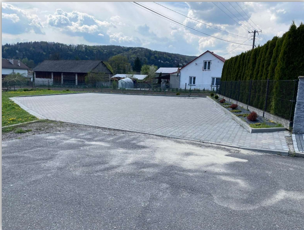
Utwardzenie terenu kostką betonową na działce nr ewidencyjnej 304 w miejscowości Kamienica Dolna
