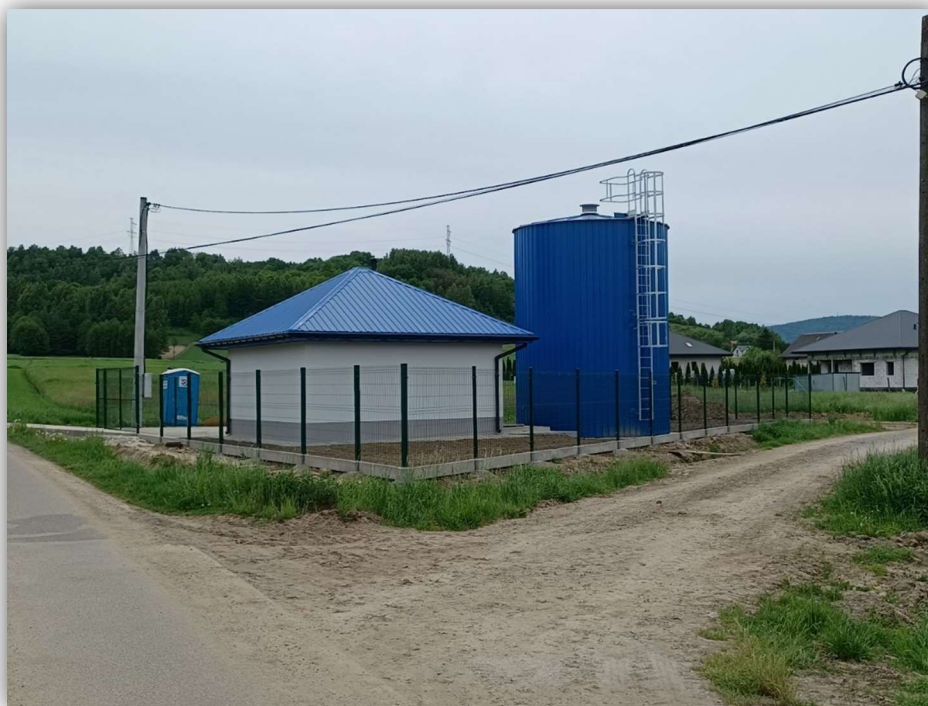
Budynek hydroforni wraz ze zbiornikiem na wodę w Kleciach.
