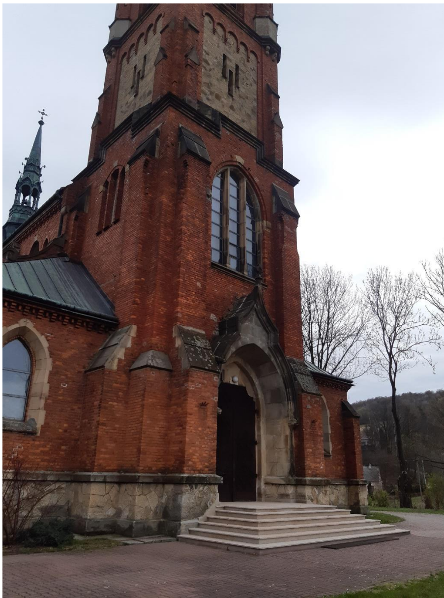
Rysunek 32 Schody zewnętrzne przy bocznym wejściu do Kościoła Parafialnego pw. Narodzenia Najświętszej Maryi Panny w Siedliskach-Bogusz
